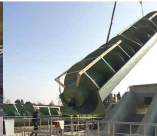
Motoren der Schneckenpumpen, noch ohne Abdeckung
