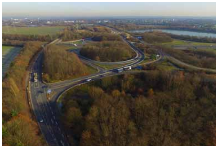
Drei Baustellen, die 2017 fortgeführt oder in Angriff genommen werden, sind der Ausbau des Radweges an der Hitdorfer Straße (links), die Sanierung der A542 und der Bau eines Kreisverkehrs im Auf- und Abfahrtsbereich der Autobahn an der Stadtgrenze zu Monheim und Leverkusen-Hitdorf. Foto: Tobias Rasch
