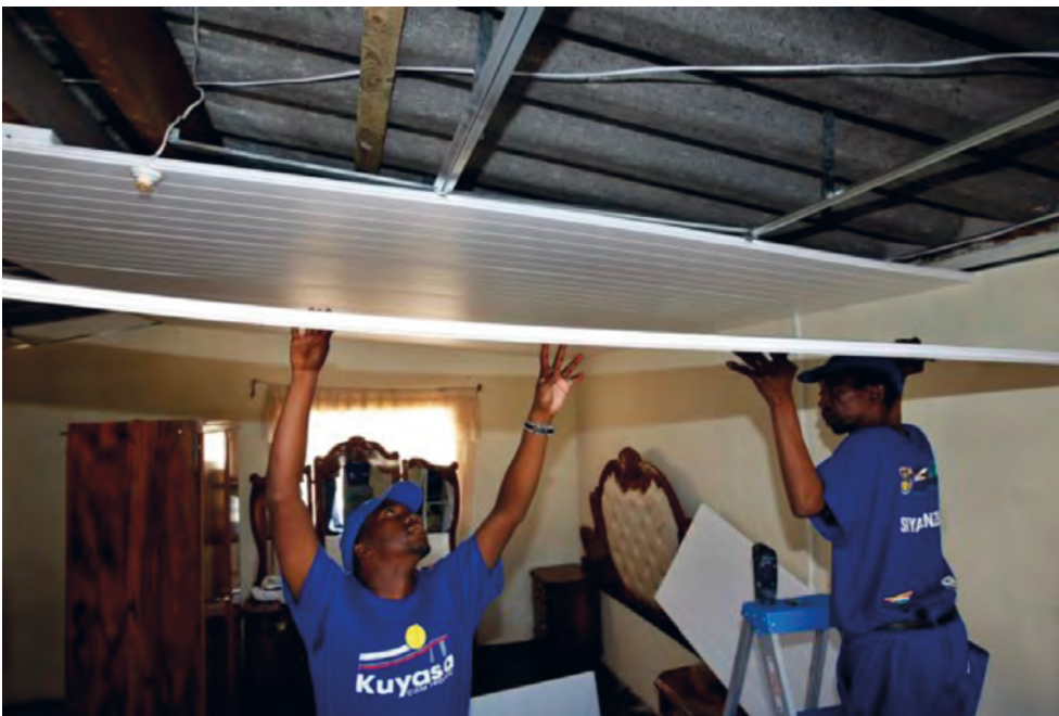
Foto 12: Montage der Deckenisolation, Quelle: Walsh et al. 2011: 22
