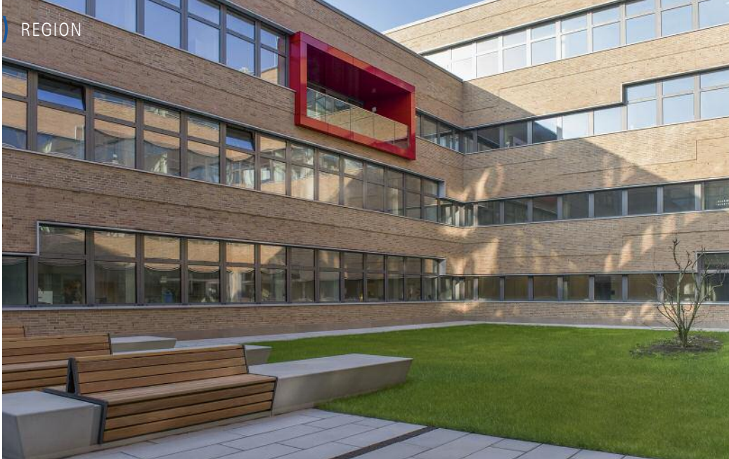
Viel Raum für Lehre und Forschung – der neue Campus der HRW
