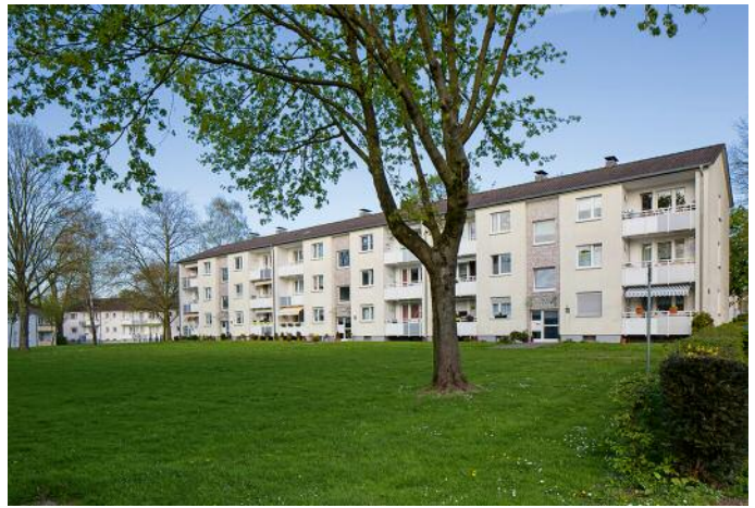
Hier wird klimagerecht saniert: Nachkriegsbebauung in Mülheim-Dümpten.
