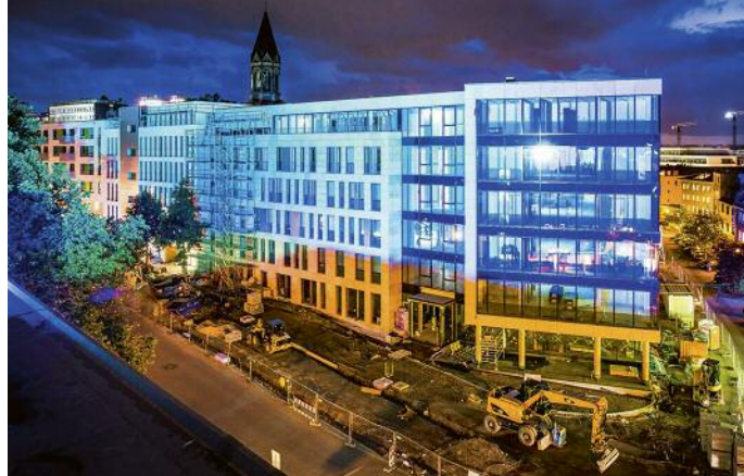
Die „Kastanienhöfe“ in der Essener Innenstadt kurz vor der Fertigstellung.
