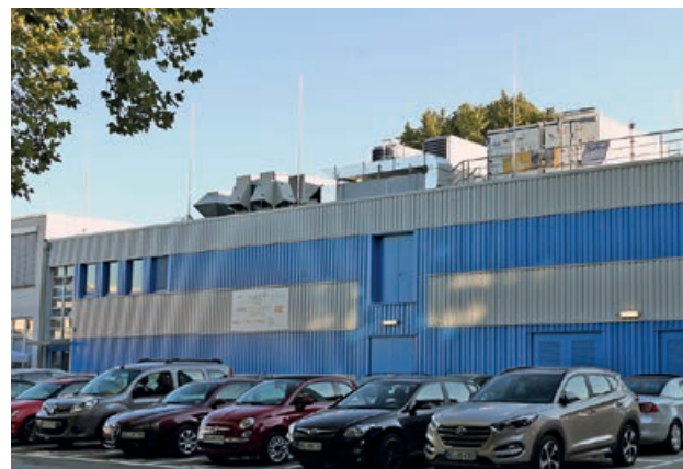
Hier wird Zukunft gemacht: An der RWTH startet der neue Großspeicher M5BAT.
