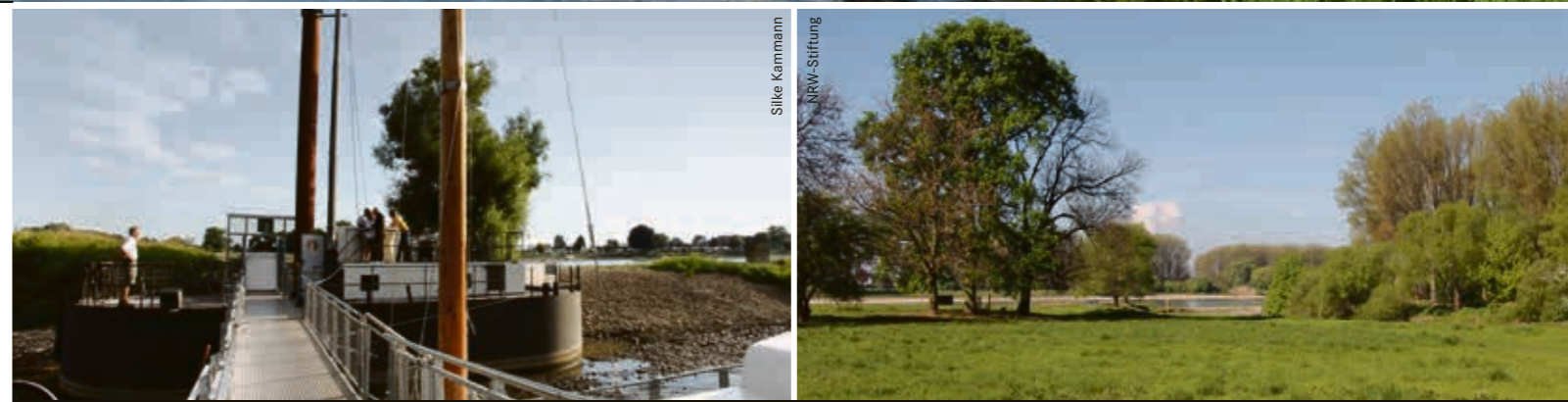
Die Aufrichtung der drei Masten im Jahr 2013 krönte den langen Kampf um die Schiffsbrücke. Viele Schwierigkeiten waren zu meistern gewesen, wie die Verlegung flexibler Versorgungsleitungen zu den schwimmenden „Pfeilern“. Rechts: Viel Grün lockt zu Ausflügen per Rad oder zu Fuß – für Autos ist die Brücke nicht erreichbar.
