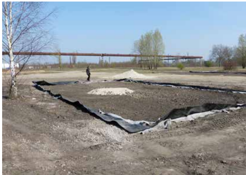
Abbildung 173: Bau der Ersatzgewässer 2012 im Landschaftspark Duisburg Nord
