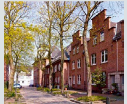
Arbeiterwohnungen in der Kettelerstraße in Neuss: Guter Wohnraum auch für kommende Generationen
