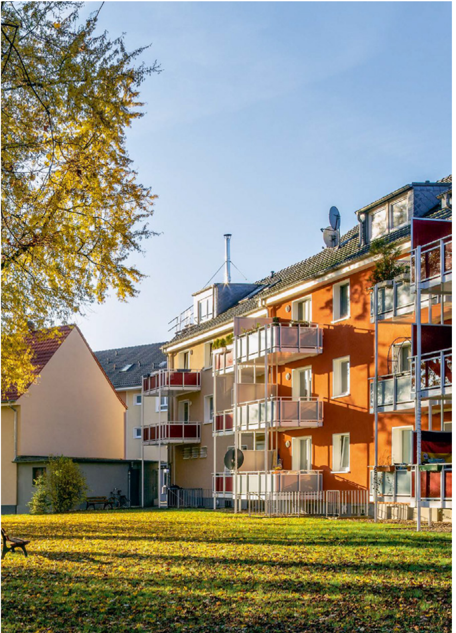
Germaniasiedlung der GAG Köln: zeitloses Konzept kommunaler Wohnungsbauanstrengungen
