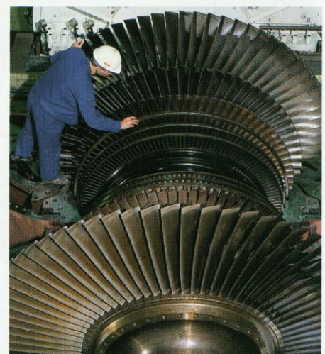
Revisionsarbeiten an der Turbine eines Steag-Kraftwerks
