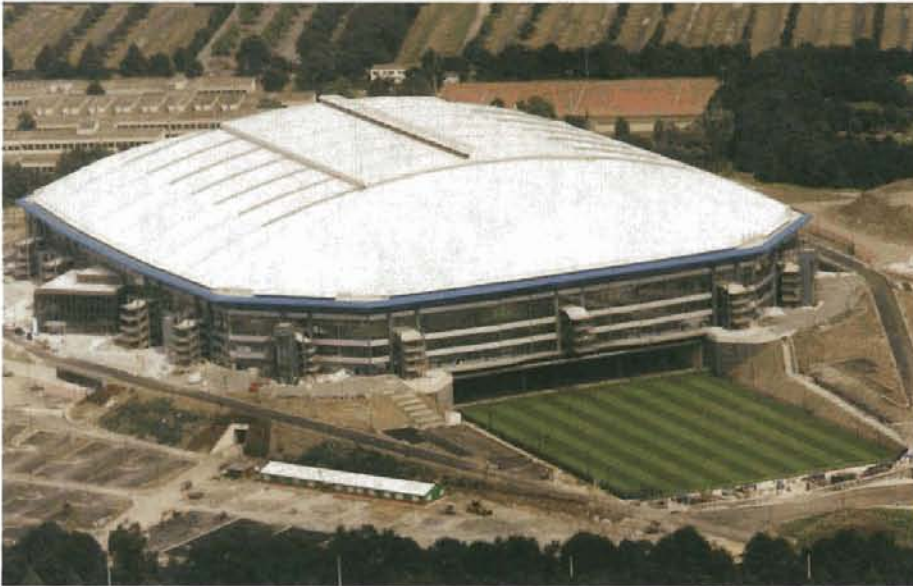
Als auch „olympiareif“ gilt das neue, mit umweltfreundlicher Technik ausgestattete Fußballstadion „Auf Schalke“ in Gelsenkirchen, hier Gesamtansicht mit ausgefahrenem Rasen.
