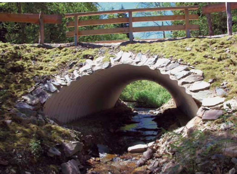
Brücken mit strukturreicher Sohle – anstatt glatte Rohre.
