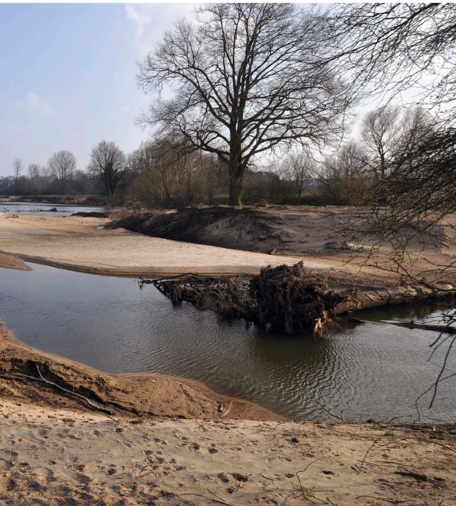
Neuer naturnaher Gewässerverlauf im ersten Winter (März 2011) nach Bauausführung.
