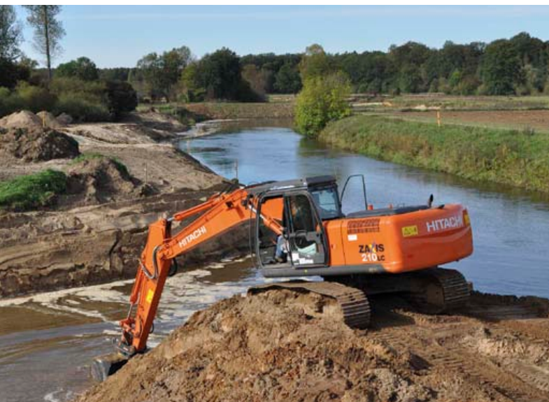
Starthilfe zur Eigendynamik: Initialgerinne werden geöffnet.
