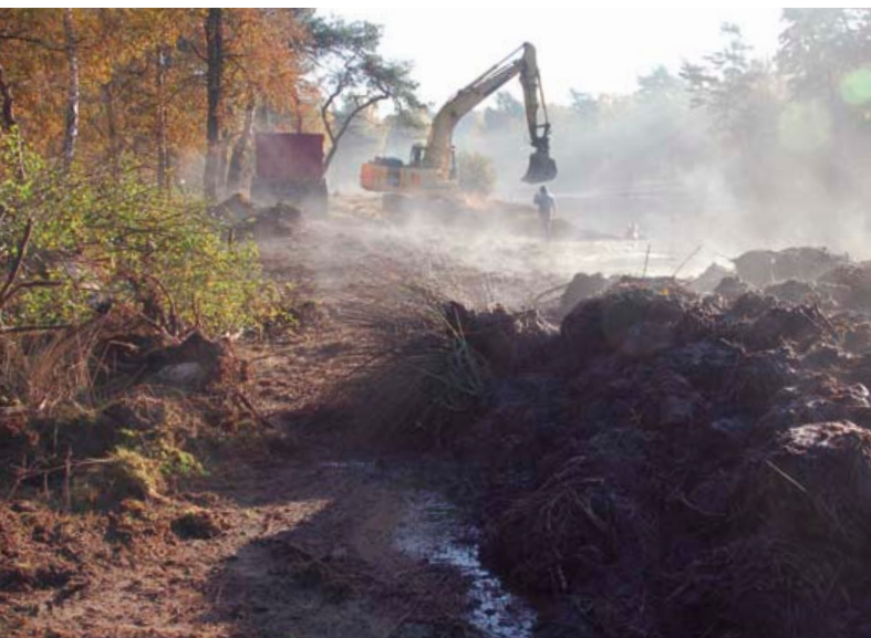
Entschlammung an einem Uferabschnitt des „Schwarzen Wassers“.
