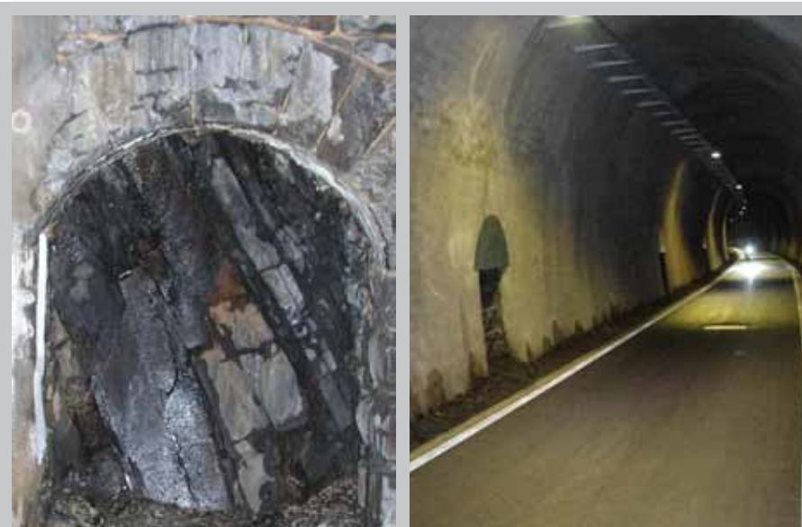
Links: Blick in eine Sicherheitsnische (vor Ausbaubeginn). Rechts: Ausgebauter Tunnel
