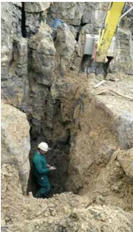
Geotoppflege „radikal“ mit Baggereinsatz
