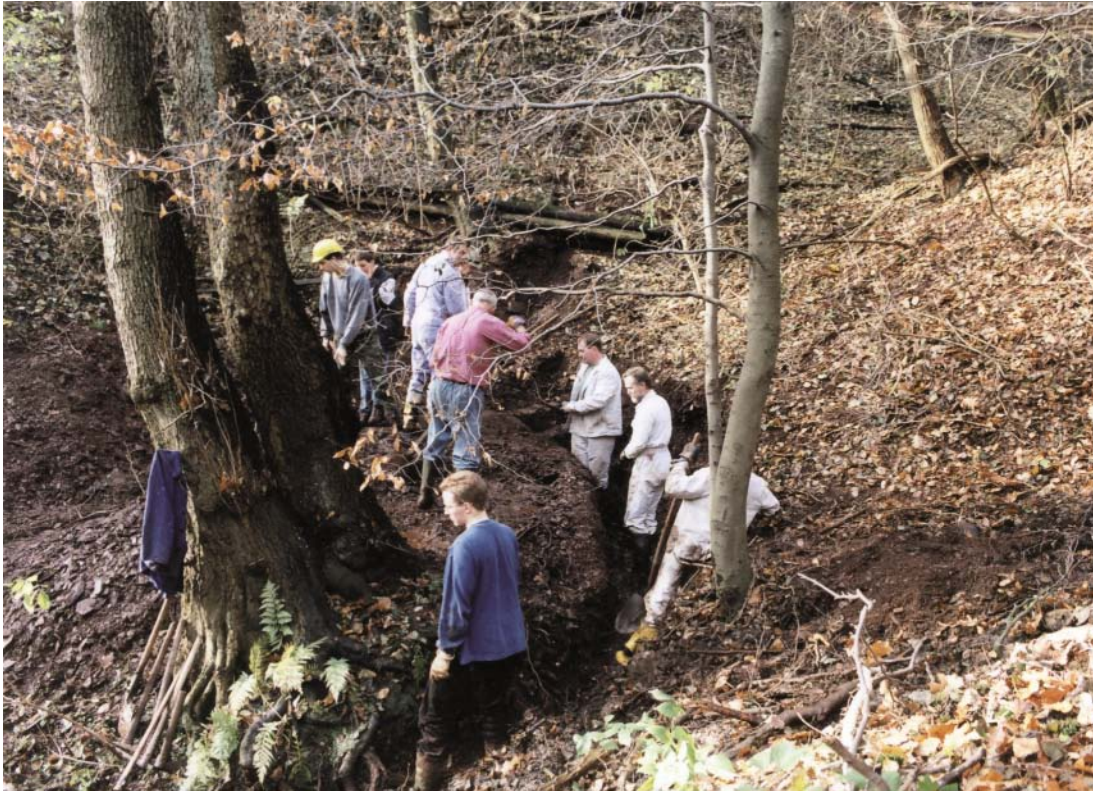
Abb. 84: Anlegen des Wassergrabens
