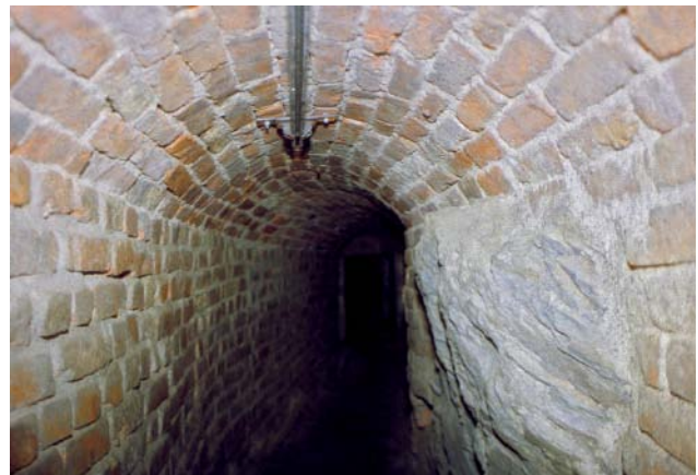
Abb. 142 Fertiges Gewölbe mit integrierter Gesteinsrippe
