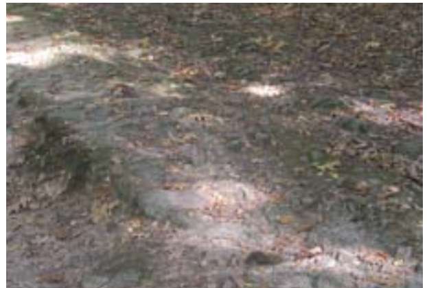
Abb. 18: Die Packlage aus hochgestellten Sandsteinen ist zu erkennen, 2005
