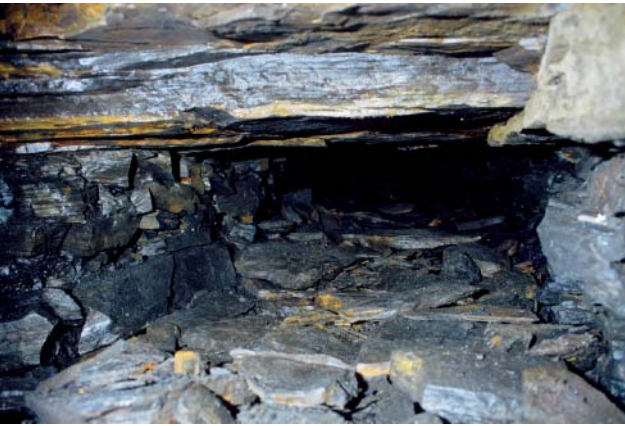
Abb. 116 Förderberg am Ende der Sumpfstrecke
