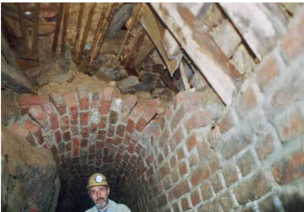
Abb. 139 Vorpfändung mit Stahlstangen, Holzstützstöcken als Hilfsausbau
