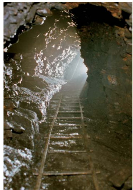
Abb. 89 Alte Förderstrecke Schleifmühle („u“), noch ohne Ausbau, (Schienen im Zuge der Aufwältigung gelegt), 2005
