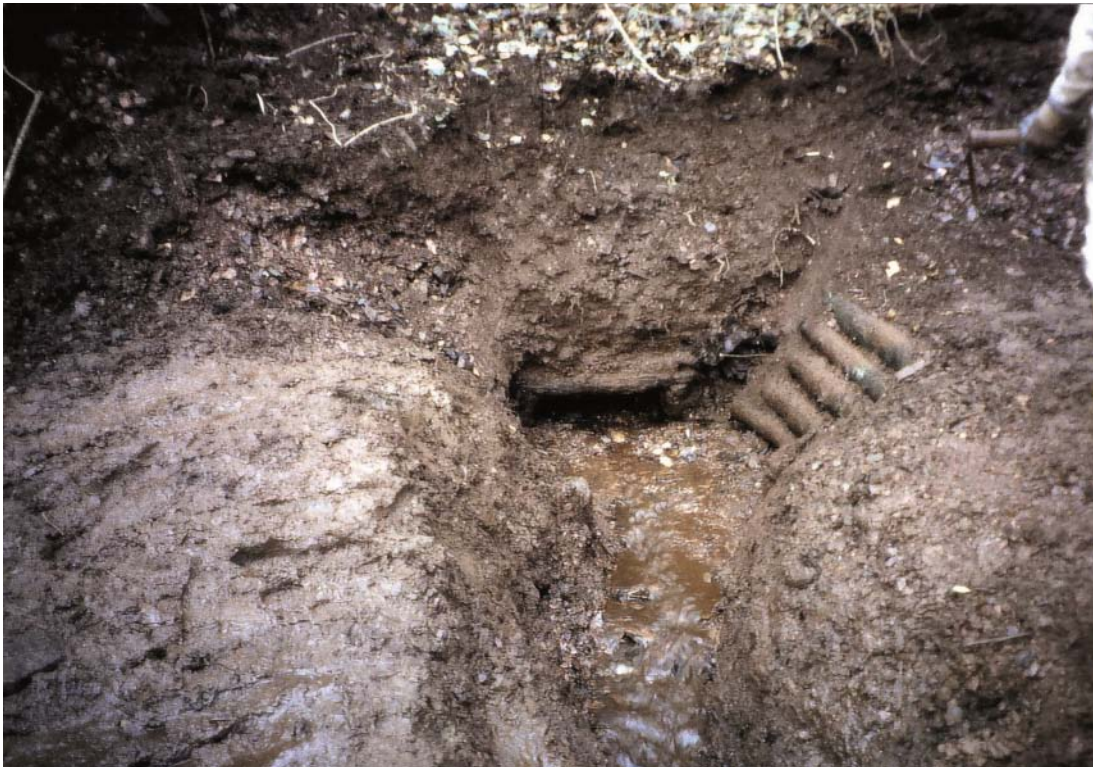
Abb. 86: Die treppenförmig gelegten Bolzen rechts dienten der Stabilisierung der Böschung.
