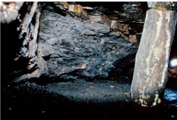
Abb. 147 Vor rd. 250 Jahren von den „Alten“ hergestellter und nicht mehr genutzter Kohlenschram am Liegenden des Flözes
