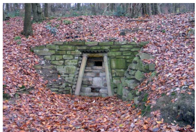
Abb. 103 Erneuerter Vorbau des Stollens Graf Wittekind Nr. 2, 2005
