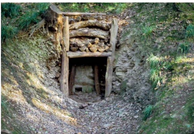
Abb. 102 Provisorischer Mundlochausbau des Stollens Graf Wittekind Nr. 2, 1997
