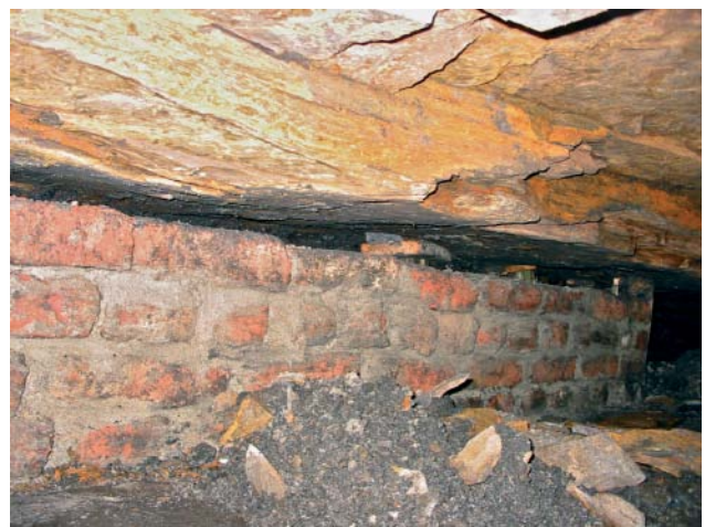
Abb. 133 Mauerarbeiten am westlichen Stoß
