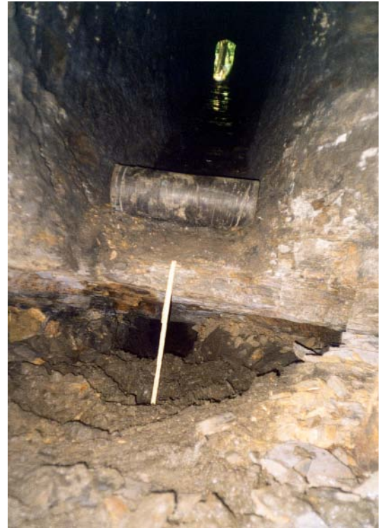
Abb. 130 Noch nicht ausge- bauter Durchschlag, oben der Förderstollen
