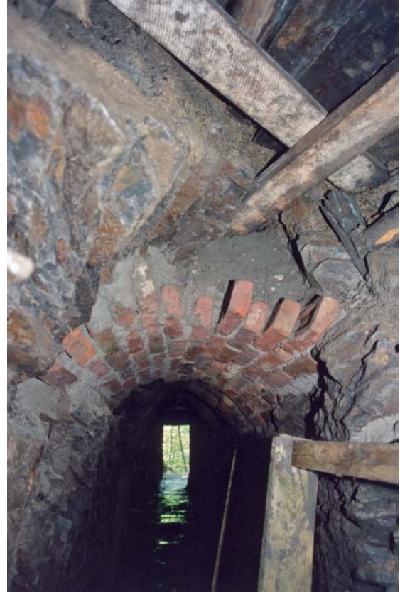
Abb. 138 Ausbau des Förderstollens Schleifmühle mit einem Ziegelstein-Gewölbe. Blick zum Mundloch.
