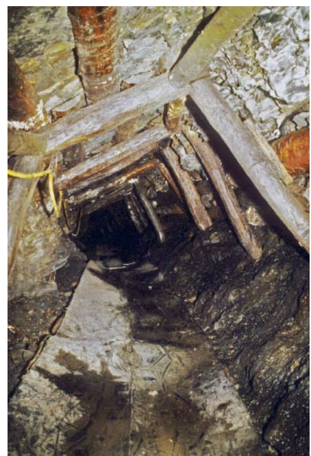
Abb. 83 Im ursprünglichem Zustand hergerichtete Abbaustrecke nach Nordosten kurz vor dem Bremsberg
