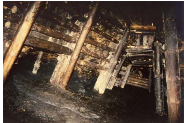
Abb. 75 Aufwältigung der Abbaustrecke nach Südwesten „q“
