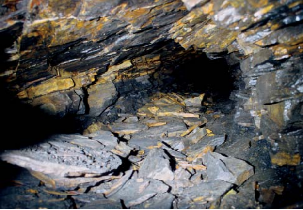
Abb. 121 Die noch nicht aufgewältigte „40-m-Strecke“
