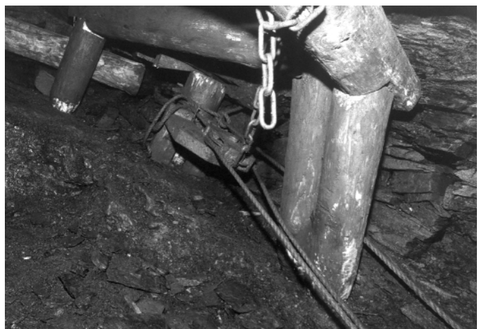
Abb. 171 Umlenkrolle vor Ort für die Seilförderung
