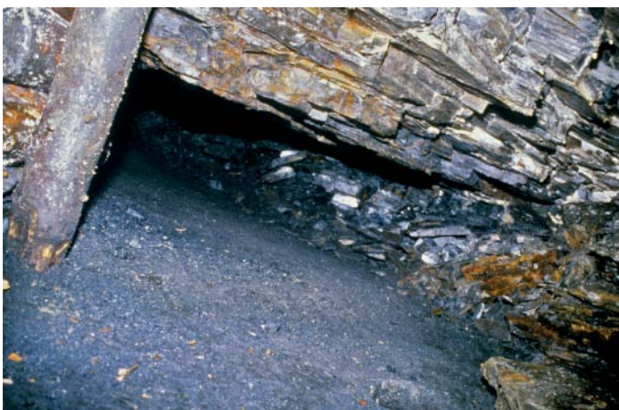
Abb. 57 Erhalten gebliebener Teil des Förderbergs, Zustand 1992
