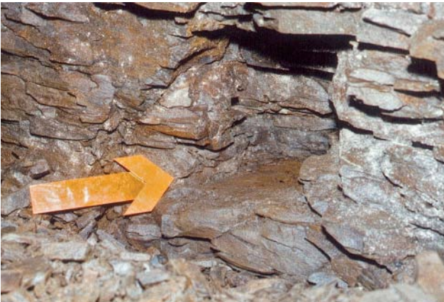
Abb. 101 Nische im südlichen Stoß zur Auflage einer Ausbau- kappe
