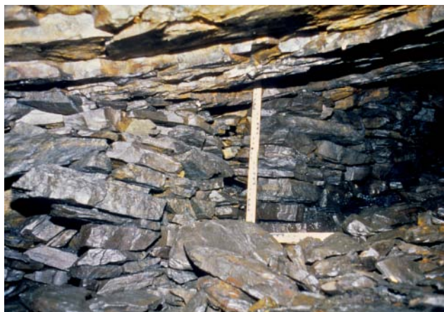
Abb. 94 Bergemauer im Bremsberg
