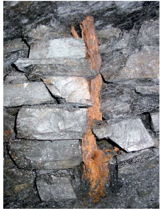
Abb. 65 In der östlichen Bergemauer des erhalten gebliebenen Förderberges integrierter Holzstempel
