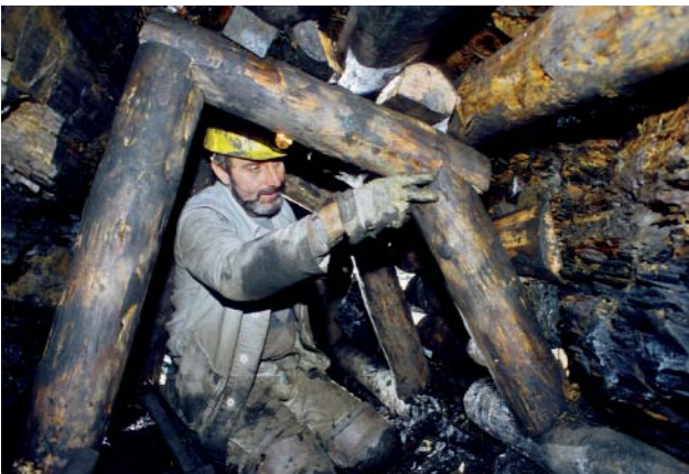
Abb. 119 Setzen eines Türstocks in der Abbaustrecke nach Süden
