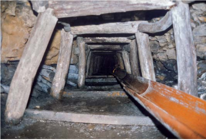
Abb. 127 Ausgebautes „Verbindungsaufhauen“ mit Rutschen
