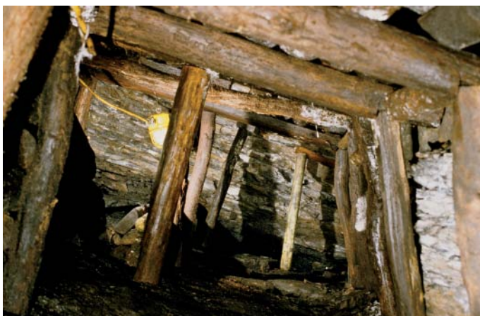
Abb. 58 Ausgeräumter Abbauhohlraum („Alter Mann“) nach Südwesten, Zustand 2005
