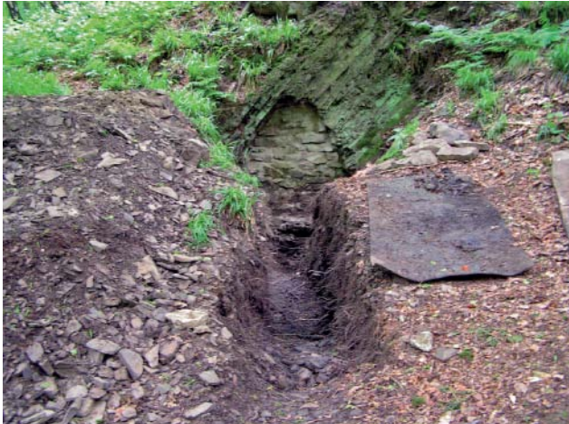
Abb. 162 Grabung „Fuchsbaustollen“: Ansicht von Südwesten
