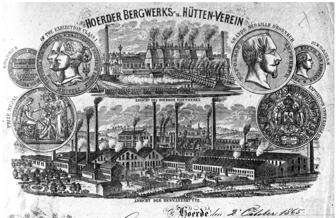
Abb. 67: Briefkopf der Hütte 1865. Oben das Hörder Eisenwerk mit fünf Hochöfen (heute Areal „Phönix West“), davor Koksöfen ohne Nebengewinnung und ein Personenzug der Bergisch-Märkischen Eisenbahn Dortmund-Soest, unten die Hermannshütte (heute Areal „Phönix Ost“, das zur Zeit zu einem See umgestaltet wird).
