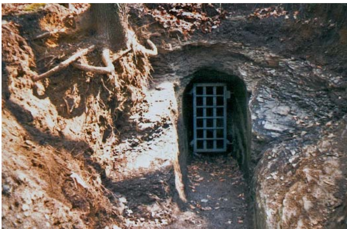
Abb. 54 Bis auf den Felsgrund freigelegtes Mundloch des Stollens Graf Wittekind Nr. 4
