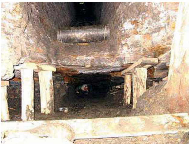
Abb. 132 Erweiterter Durchschlagsbereich mit provisorischem Holzausbau, vor dem Mauern
