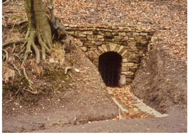
Abb. 71 Fertiggestellter Vorbau des Förderstollens Wittekind, 1991
