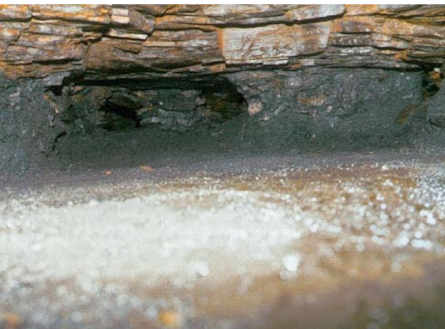
Abb 73 Der „Alte Mann“ gegenüber dem Übergang Stollen/Abbaustrecke mit stehengelassenen Kohlepfählern
