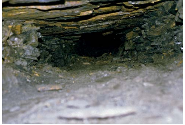
Abb. 122 Ein Aufhauen aus der „40-m-Strecke“ nach Südosten
