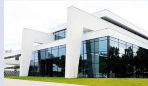
Zwei 58 Meter lange, freitragende Zweigelenk-Spannbetonbinder tragen die zweitgeteilten, optisch schwebenden Flachdecken. Bis auf schmale Stützen vor den wandhohen Fensterebenen bleibt das Innere der Halle stützenfrei. In Fachkreisen und in der Öffentlichkeit findet das Pahlkebad große Beachtung und überregionale Anerkennung.
