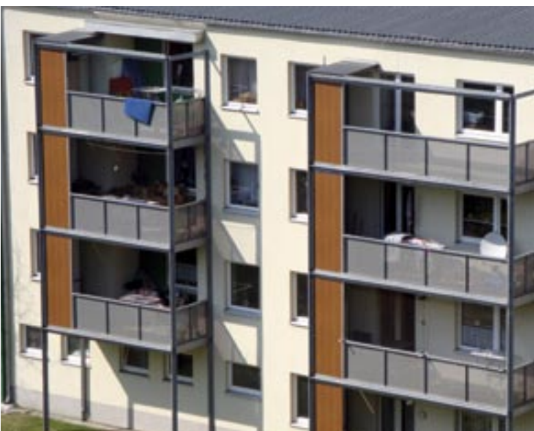
Neue Balkone mit seitlichen Abstellchränken: Hier können Sitzauflagen, Gießkanne und gelber Sack geordnet und gut erreichbar aufbewahrt werden.
