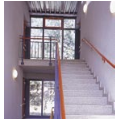
Die gute Belichtung und Beleuchtung des Treppenhauses sorgt für Sicherheit. Kontrastreiche Farben und die beidseitigen Handläufe erleichtern die Orientierung auch für seh- und gehbehinderte Menschen. Einbrunner-Str., Düsseldorf-Wittlaer
