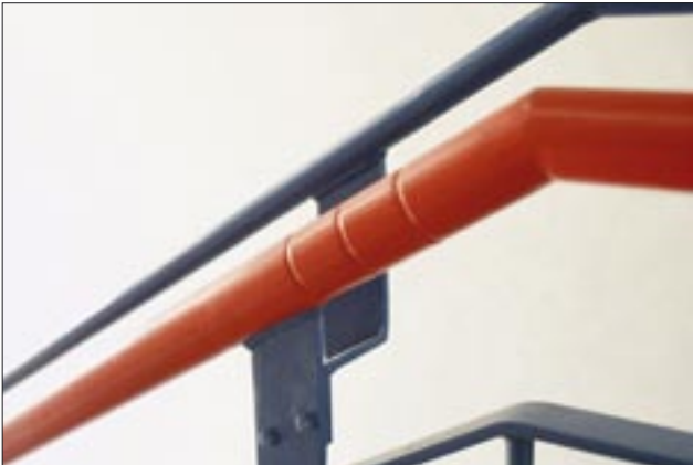
Integrierte taktile Elemente erleichtern die Orientierung, so z.B. drei Rillen = dritter Stock.
