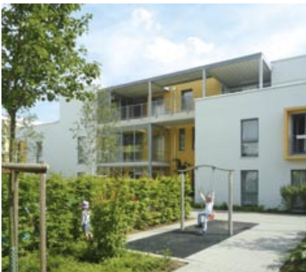
Die verglasten Laubengänge schützen gleichzeitig gegen Lärm.
