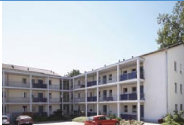
Laubenganghäuser im 2. Bauabschnitt.
