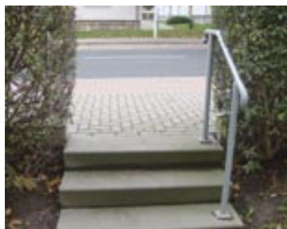
Wer sich festhalten kann, schafft Stufen viel leichter. Deshalb sollte auch dann ein Handlauf angebracht werden, wenn es die Landesbauordnung noch nicht vorschreibt – sogar bei nur einer Stufe.
