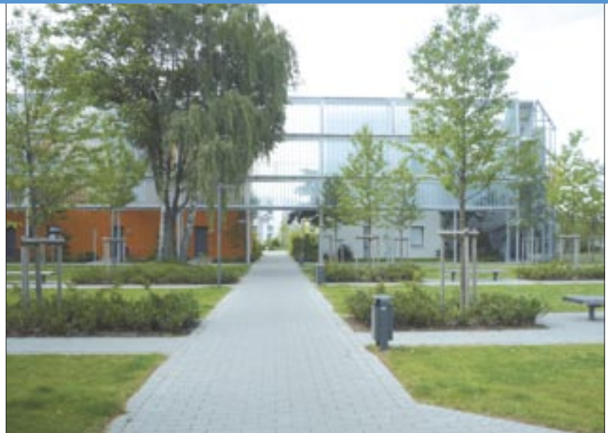
Die verglasten Laubengänge schützen gleichzeitig gegen Lärm.
