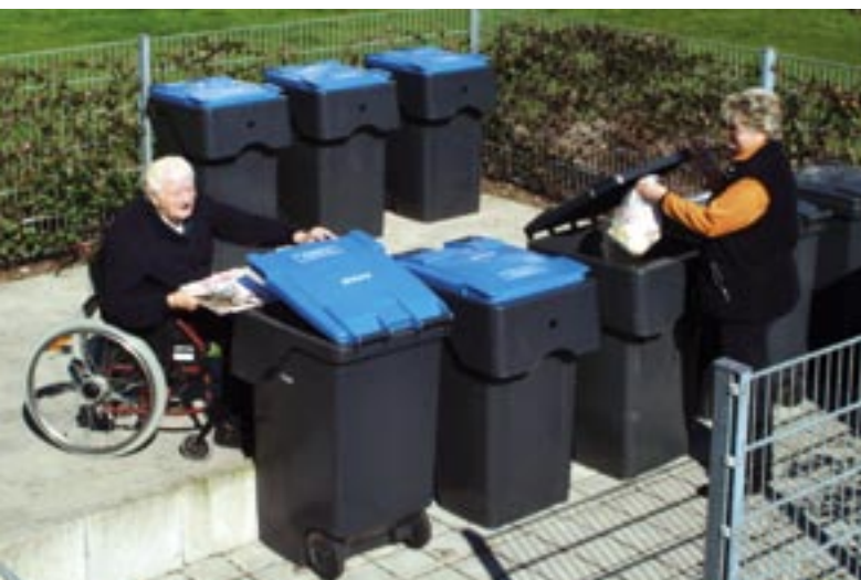
Ein gut geplanter Müllcontainerplatz: Die erhöhte Anfahrt macht das Öffnen der Deckel leicht für alle. Arnsberg-Unterhüsten
