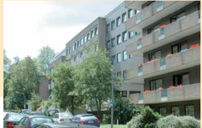
Straßenansicht vor der Modernisierung
