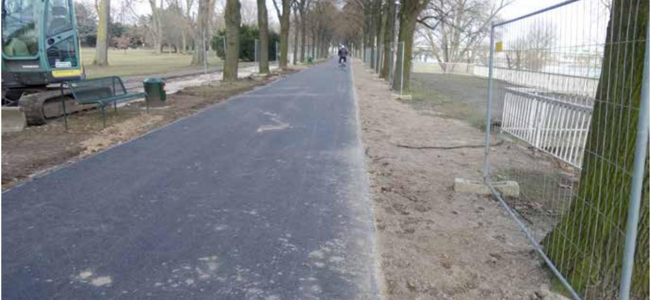
Auf rund 2 km wurde der Geh- und Radweg am Niederländer Ufer erneuert. Auf diesem Abschnitt war komfortables Radeln aufgrund der erheblich beschädigten Plattierung nicht mehr möglich. Mit einer neuen Asphaltdecke in einer Breite von 3,60 m wurde nun ein komfortables und attraktives Stück Radinfrastruktur geschaffen.
