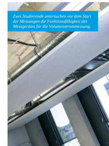
Zwei Studierende untersuchen vor dem Start der Messungen die Funktionsfähigkeit des Messgerätes für die Volumenstrommessung.
