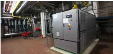
*Das Sanierungsmodell: Die auf acht Fachabteilungen verteilten 420 Betten im Johanna-Etienne-Krankenhaus werden mit modernisierten Brennwertkesseln sowie einem neu installierten BHKW mit Wärme und Strom versorgt. Foto: Stadtwerke Neuss*
