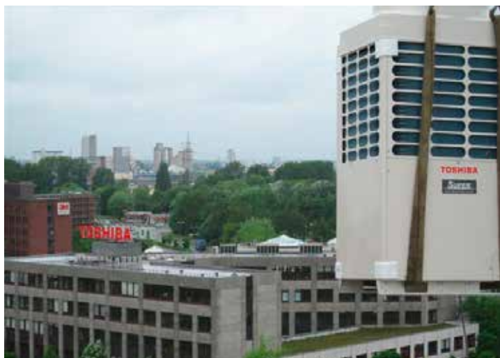
Einbringung des Klima-Außengeräts in das Holiday Inn Neuss. Foto: Toshiba
