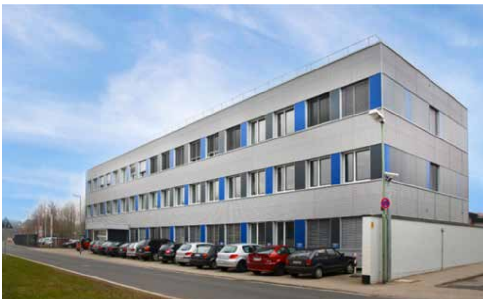
Die Selex ES GmbH setzt bereits seit 2007 auf das Service-Modell der Stadtwerke Neuss. Foto: Stadtwerke Neuss
