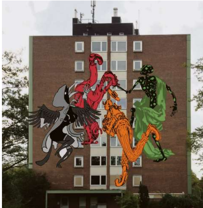
▲ Dies war der erste grobe Entwurf für die Fassadenmalerei an der Hülchrather Straße 37. Mittlerweile ist das Kunstwerk fertig. Ähnlichkeiten zum Erstentwurf sind auf jeden Fall noch erkennbar.
