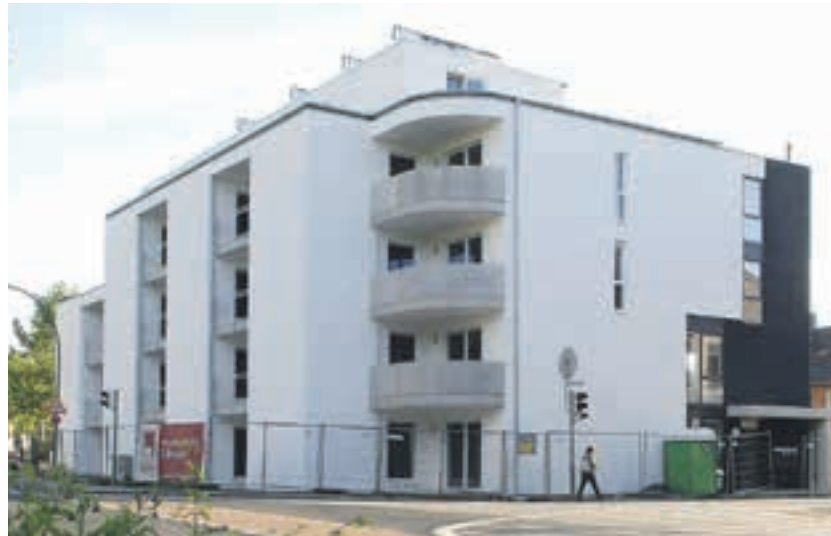
▲ Die Neusser Furth ist ein beliebter Wohnort: An der Marienstraße 89 stellte die Neusser Bauverein AG jetzt 16 attraktive Wohneinheiten fertig.
