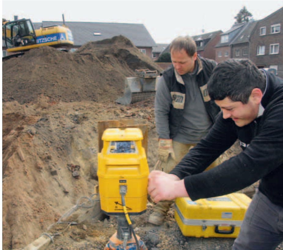
Die Aushubarbeiten an der Marienstraße für ein 4-geschossiges Mehrfamilienhaus sind bereits im vollen Gange.
