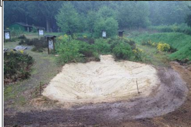
Abbildung 15: Der neue mit Dernothon® abgedichtete Gewässerkörper (Foto: 30.4.2014, BSMW. Boomers)
