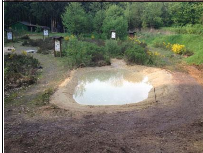
Abbildung 16: Der neue mit Dernothon® abgedichtete Gewässerkörper wird mit Wasser befüllt (Foto: 30.4.2014, BSMW. Boomers)
