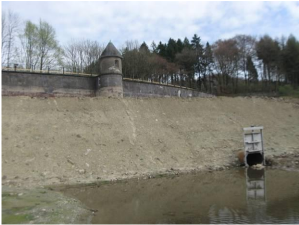
Abbildung 63: Gewässer D: Restwassertümpel Staumauer
