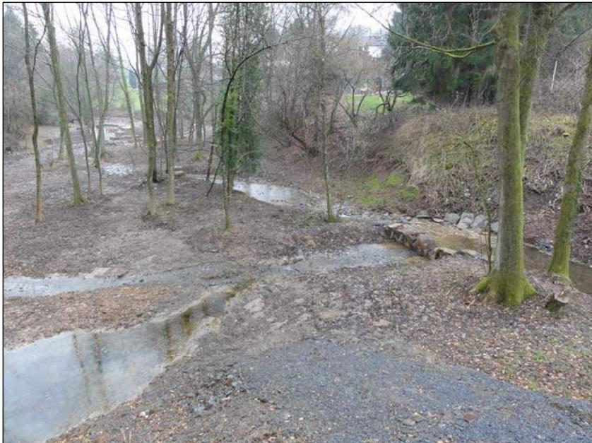
**Abb. 54:** Statt konventioneller Regenüberlauf- und -rückhaltebecken wurde 2012 unter Einsparung großer Kosten am Weinsberger Bach im Bereich Pereskotten ein Damm zur Hochwasser-Rückhaltung errichtet. Damit einher ging die im Bild (links) zu sehende Renaturierung der Bachau. Parallel bekam der Weinsberger Bach im Bereich der Kleingartensiedlung Gabelsbergerstraße ein neues, offenes Bett (Foto: 19.03.2013).
