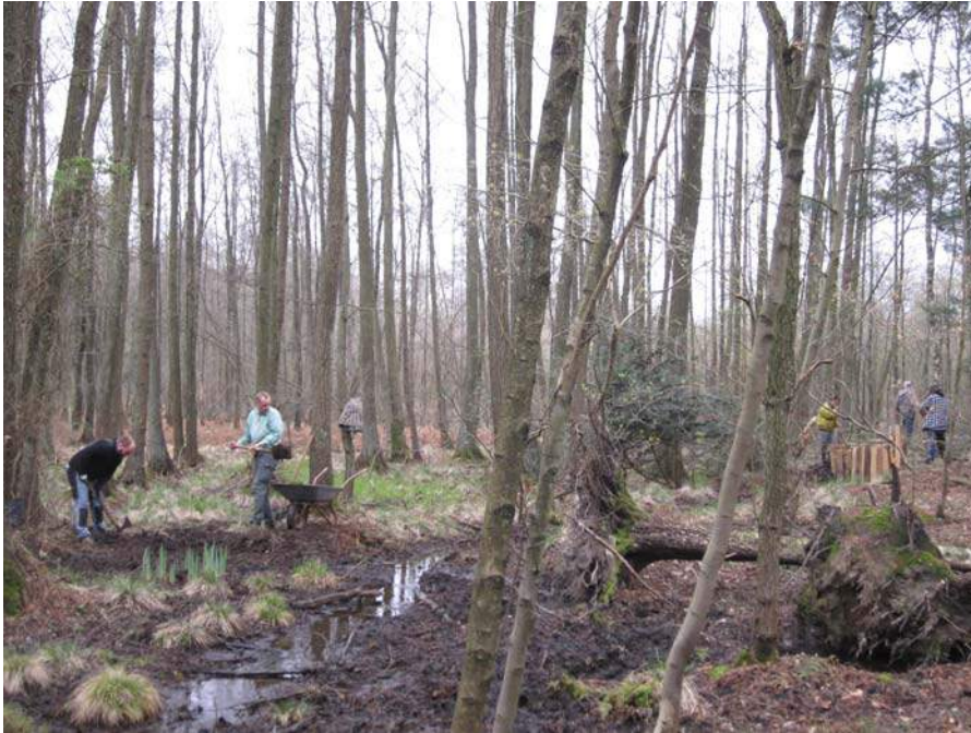
Abbildung 21: Arbeitsinsatz des RBN am 31.3.2012. Links im Bild wird der künstliche Damm des tief eingegrabenen Kniebaches abgetragen, um den im Hintergrund sichtbaren Bruch- und Moorwald wieder stärker an das ursprüngliche Wasserregime anzubinden. Im Bild rechts sichtbar der Bau einer Stauschwelle zur stärkeren Gewässerrückhaltung (Foto, Boomers, BSMW).
