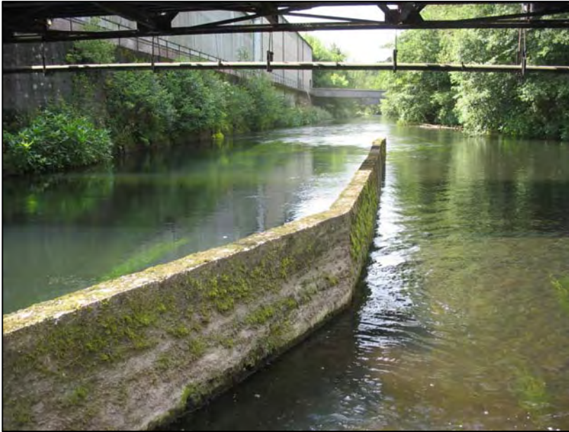
Abb. 84: Mündung des Kraftwerkerauslaufs in das Flussbett unterhalb der Beyenburger Wupperschleife
