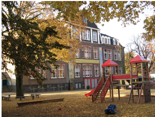
Das alte Schulhaus in der Elsässer Straße: Der neue Besitzer des Gebäudes wird nicht pünktlich mit der Modernisierung fertig. Deshalb muss die Kita Don Bosco in ein Ausweichquartier.
