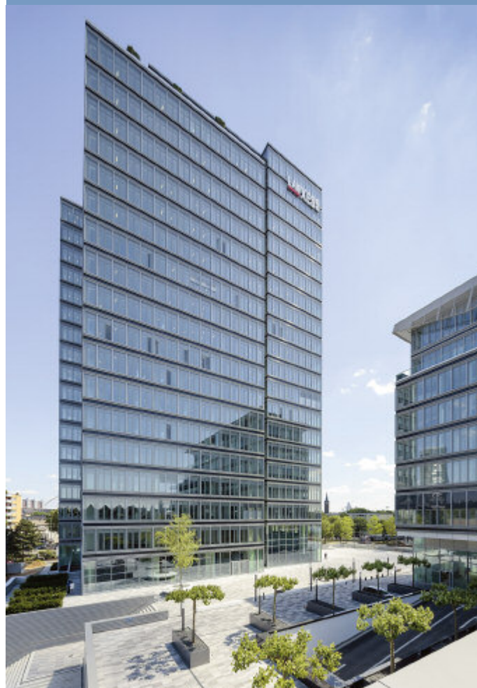
Den Kölner Gebäudekomplex „maxCologne“ versorgte Elomech mit Starkstrom.
