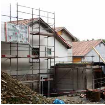
Die Baustelle des neuen Kinder- und Jugendhospizes im Herbst 2014. In den Osterferien 2015 war das Haus dann schon fast vollbelegt.
