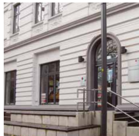
In das Mehrgenerationenhaus/Haus der Begegnung kommen seit dem Umbau noch mehr Besucher aus der Solinger Nordstadt.
