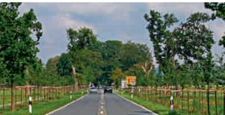
Sanierter Bereich der Fürstenallee im Sommerlaub
