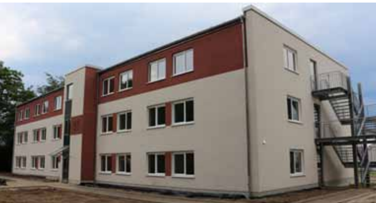
Der Neubau am Winkelsweg wurde vor wenigen Tagen fertiggestellt und ist nun bezugsfertig. Das Gebäude bietet Platz für bis zu 150 Asylsuchende.
