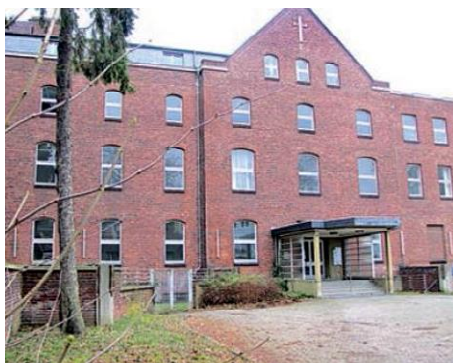
Das ehemalige Krankenhaus an der Hospitalstraße.
