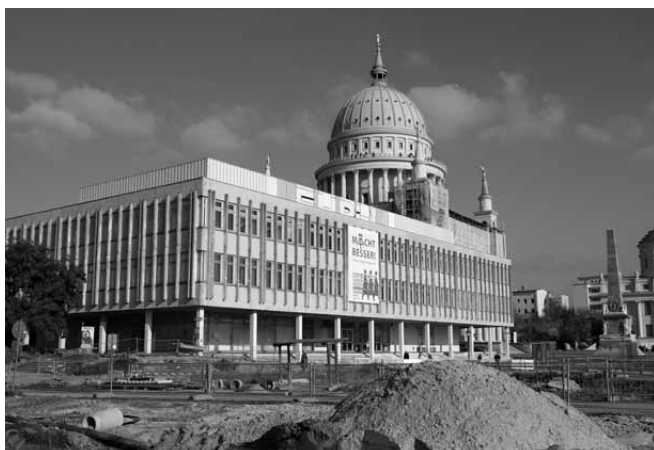
Baugrube für das neue „Stadtschloss“ gegenüber der Fachhochschule Potsdam Am Alten Markt im Oktober 2010 (Foto: privat)
