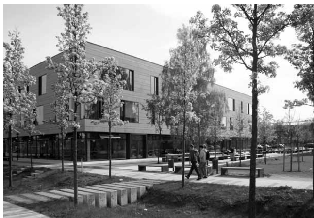
Zentralgebäude auf dem Campus der Fachhochschule Potsdam (Foto: Angela Müller FH Potsdam)
