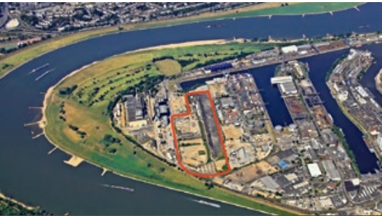
Auf diesem Areal im Düsseldorfer Hafen wird der neue Logistikkomplex entstehen.
