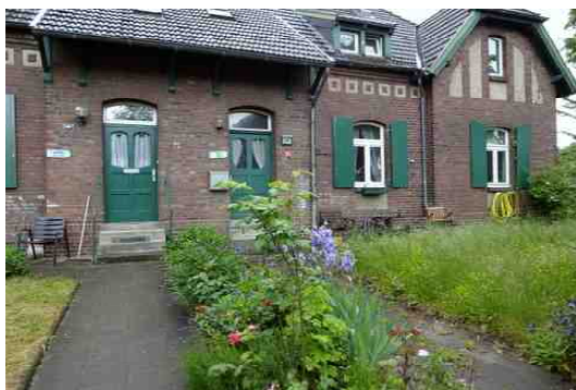
Arbeitersiedlung Rheinpreußen, Duisburg-Homburg.
