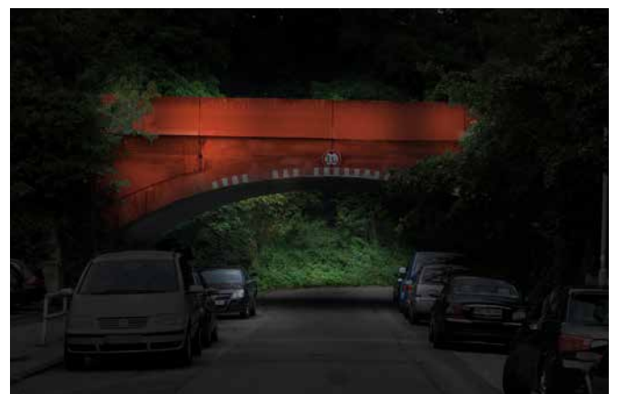
Die Unterführung „An der Landwehr“
