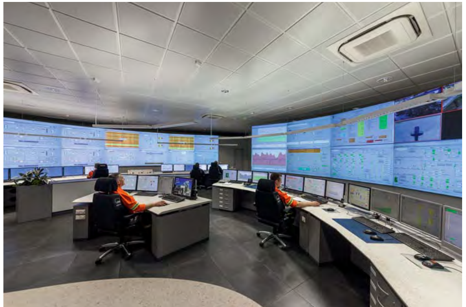
Leitwarte zur Verteilung der Kuppelgase bei der Saarstahl AG in Völklingen.
