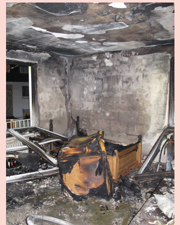
Bei Temperaturen von über 1.000 Grad Celsius fällt bei einem Zimmerbrand der Putz von Decke und Wänden. Von der Einrichtung bleibt oft nicht mehr viel übrig.
