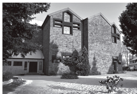
1962 - Energetisch und sturmsicher umgebaute Kirche
