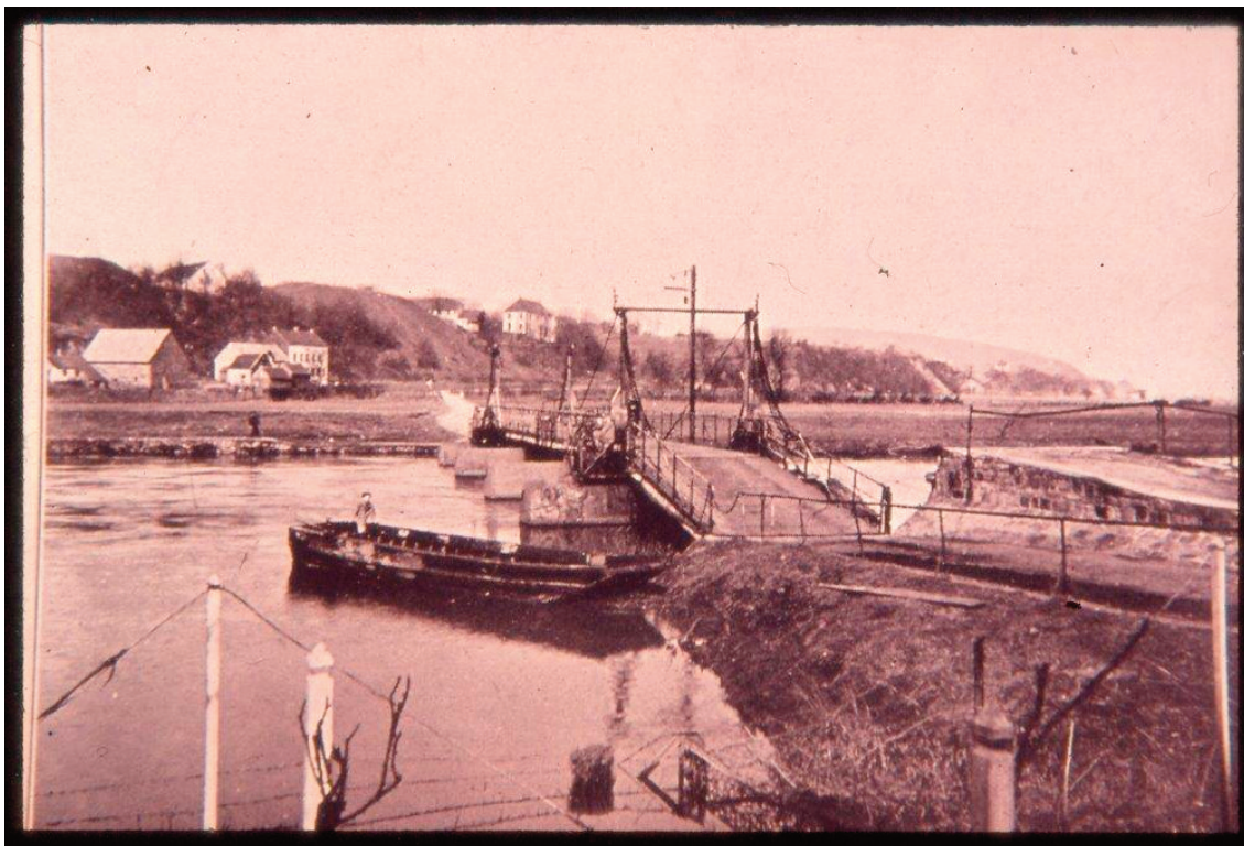
Die als Notbrücke wieder aufgebaute Kampmannbrücke in KUPferdreh - Fotoarchiv Ruhrmuseum
