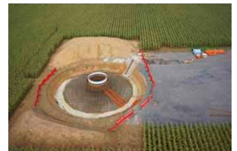
Günstiger Standort auf einem Acker: Fundament für die neue Windkraftanlage Repelen.
