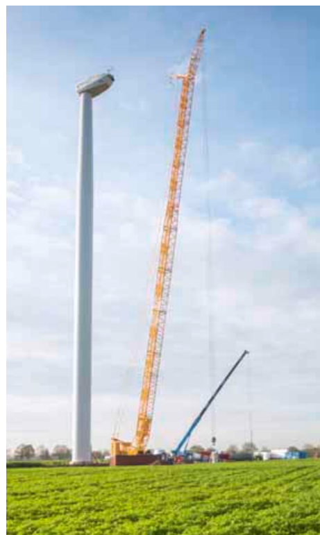
Um den 146 Meter hohen Mast der Windkraftanlage aufzurichten zu können, benötigte der Kran eine besonders befestigte Stellfläche.
