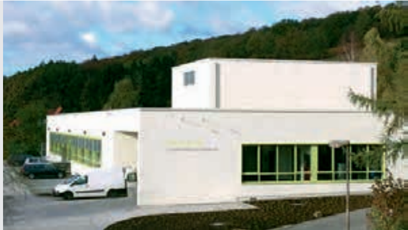
Die neue Cook-&-Chill-Küche von Rebional
