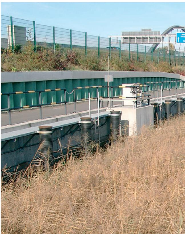
Bodenfilter in Betonbauweise mit senkrecht hochgezogenen Dränrohren
