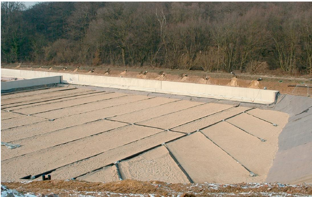
Drainageaufbau mit Verzweigung
