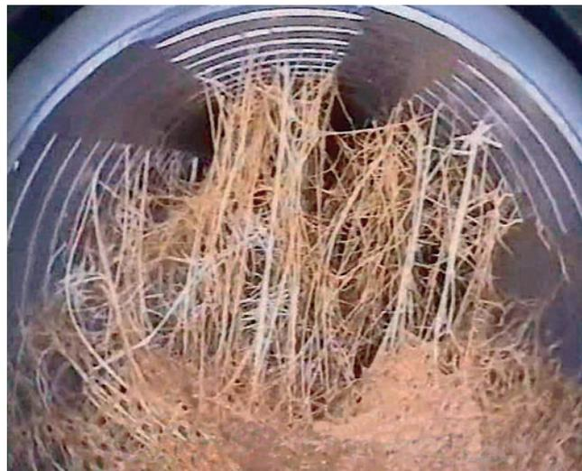
Das gesamte Dränsystem muss für eine Inspektion und für Spülzwecke zugänglich sein. Dies setzt voraus, dass geschlossene Sammelleitungen an die Böschungsoberkante des Filters (Bild 5.11) oder in Inspektionsschächte außerhalb des Filters geführt werden. Kontrollschächte im Filter (unterhalb Stauziel) haben sich auf Grund der bestehenden Kurzschlussgefahr und der eingeschränkten Zugänglichkeit (Einstau, Sedimentablagerungen) nicht bewährt.
