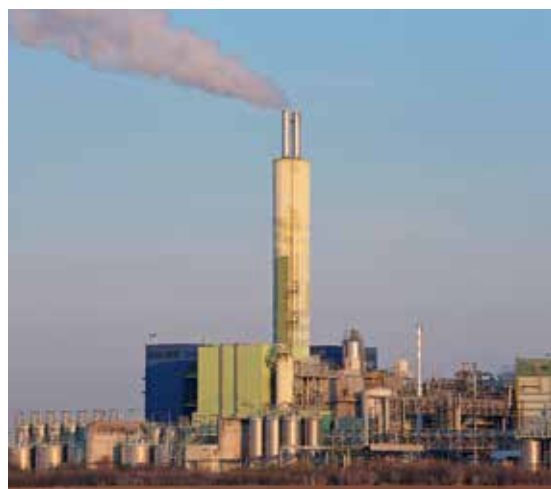
Wie kann die Abwärme in thermischen Abfallbehandlungsanlagen energetisch genutzt werden? Eine Studie hierzu soll weitere Potenziale aufzeigen.
