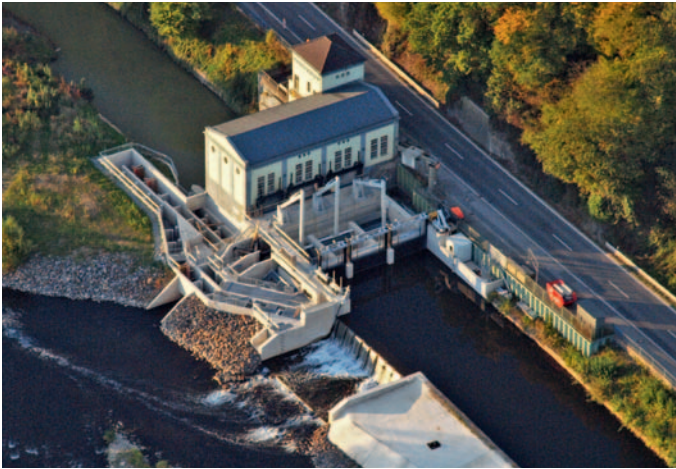
Fischpass mit Fischschutzsystem Unkelmühle, Sieg
