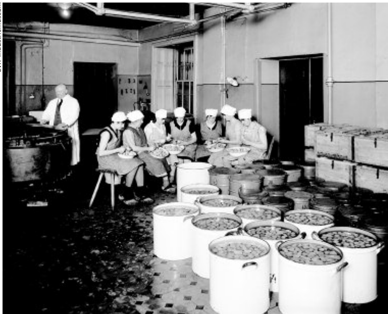
Küche im Ledigenheim des Walzwerks Neu-Oberhausen. Die Köchinnen versorgten unverheiratete Walzwerksarbeiter, 1930
