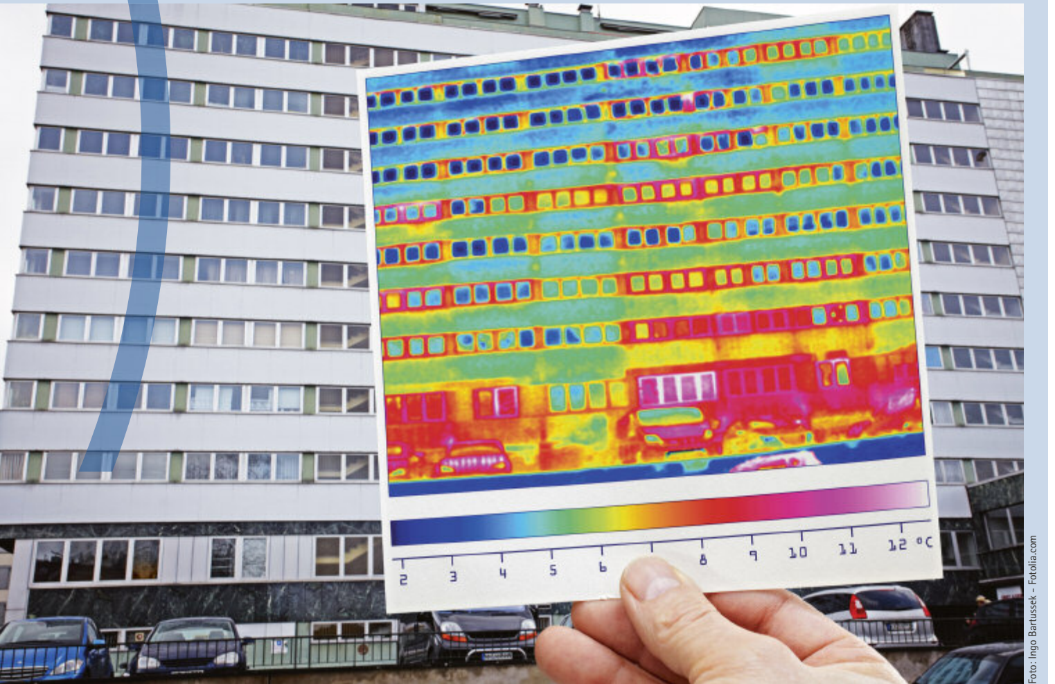
Wo geht am meisten Energie verloren? Die Wärmebildkamera enttarnt Schwachstellen an der Fassade.
