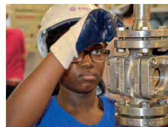
Ganz konzentriert setzt Schülerin Appiah eine Rohrleitung im Chemietechnikum zusammen.
